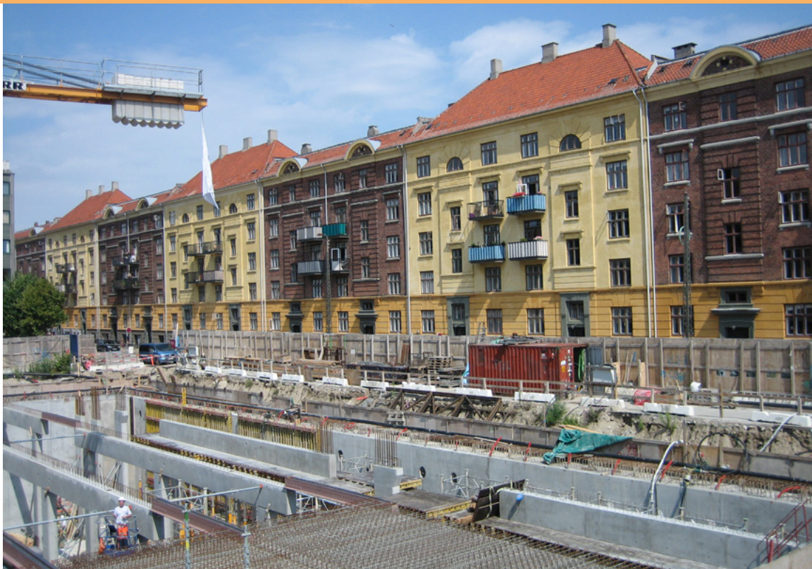
Строительство 400-местного подземного паркинга с жилыми квартирами наверху в микрорайоне Исландская Набережная в Копенгагене, Дания.
