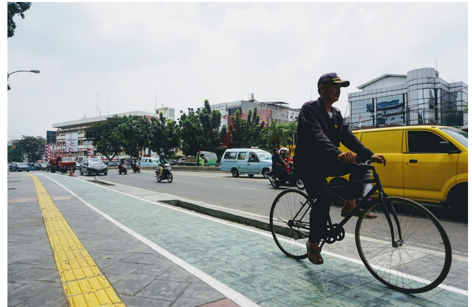
Gambar 16: Pesepeda sedang melintasi jalur sepeda yang baru dibangun di Jalan Jatinegara Timur, Jakarta Timur
