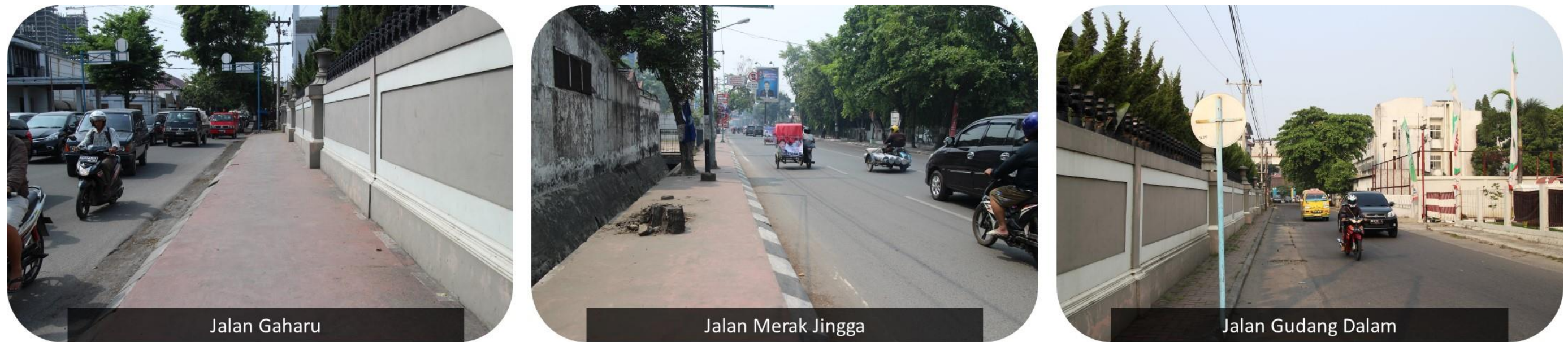
Gambar 3. 46 Kondisi muka bangunan pasif pada beberapa jalan di Pusat Kota Medan
