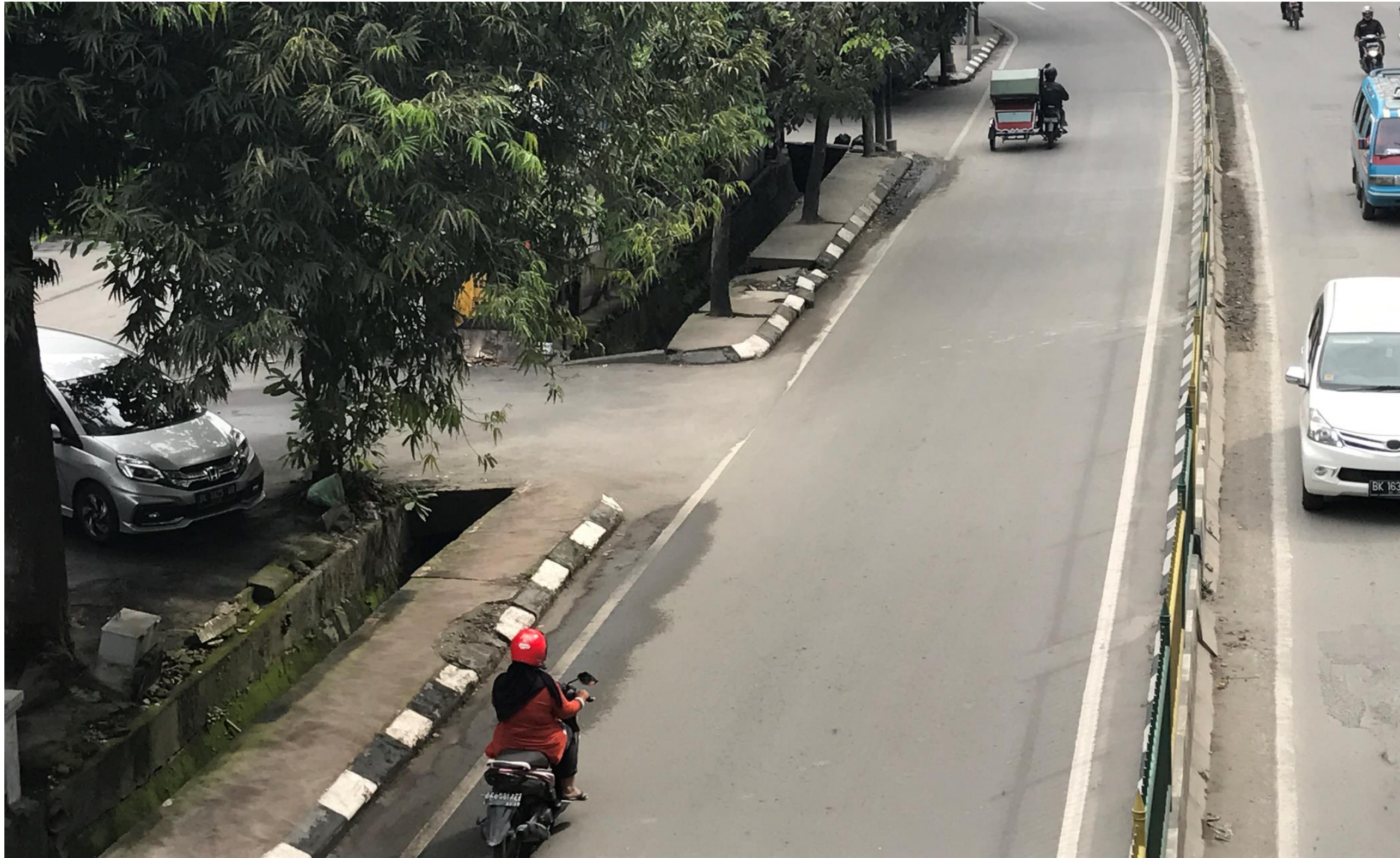
Gambar 3. 20 Foto kondisi eksisting driveway pada Jalan Guru Patimpus, Medan
