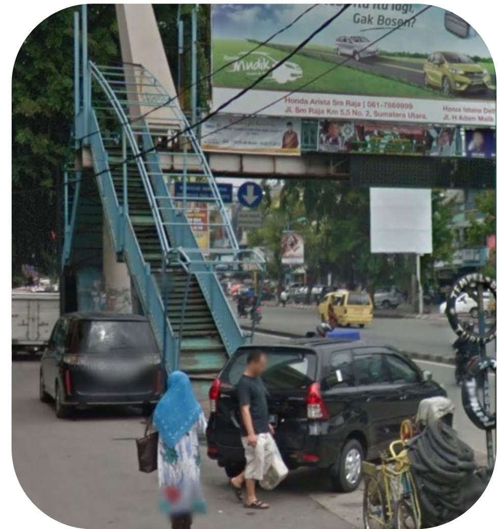
Gambar 3. 43 Kondisi JPO di dekat Simpang Sekip
