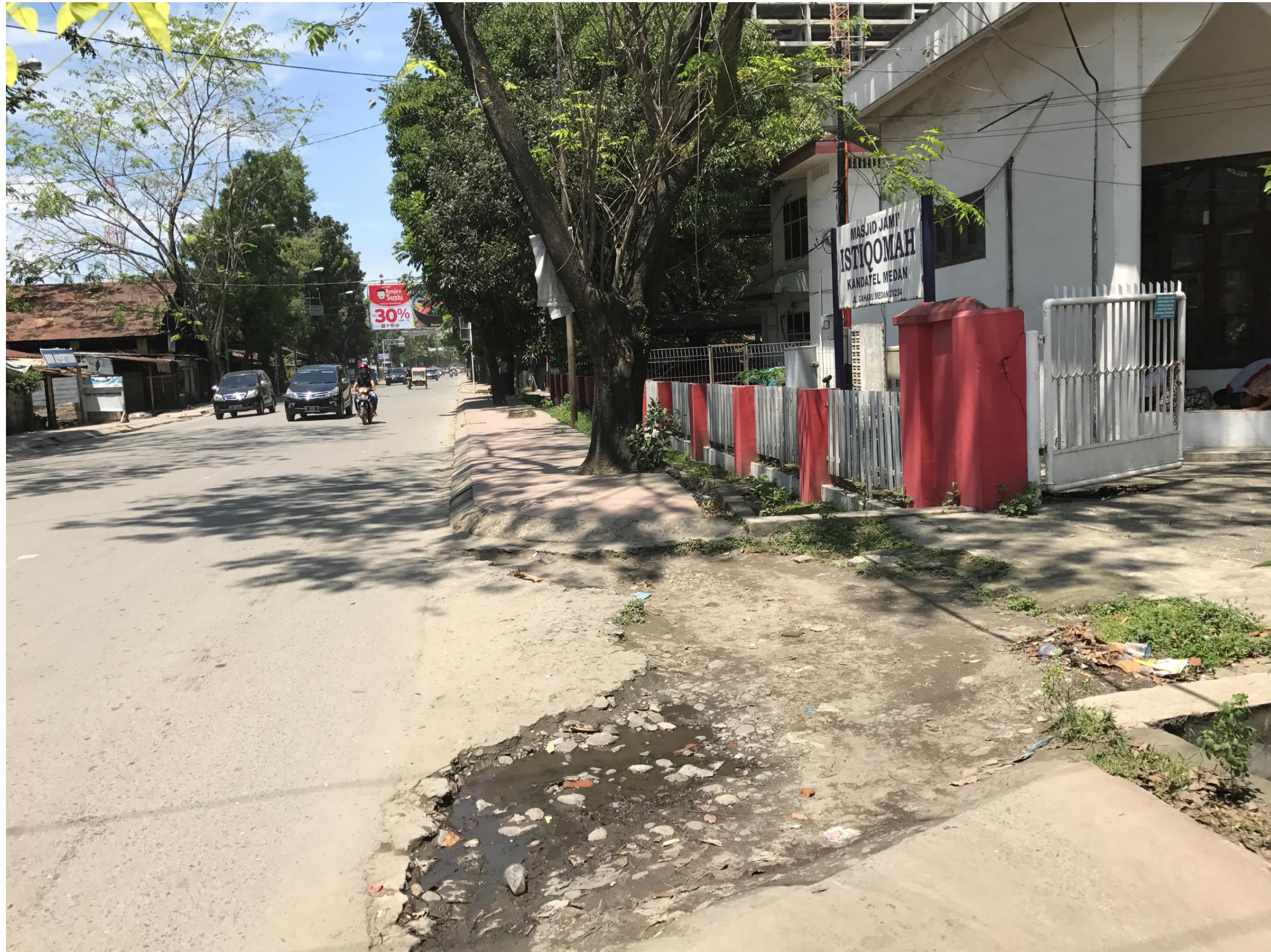
Gambar 3. 22 Foto kondisi eksisting driveway pada Jalan Gaharu, Medan
