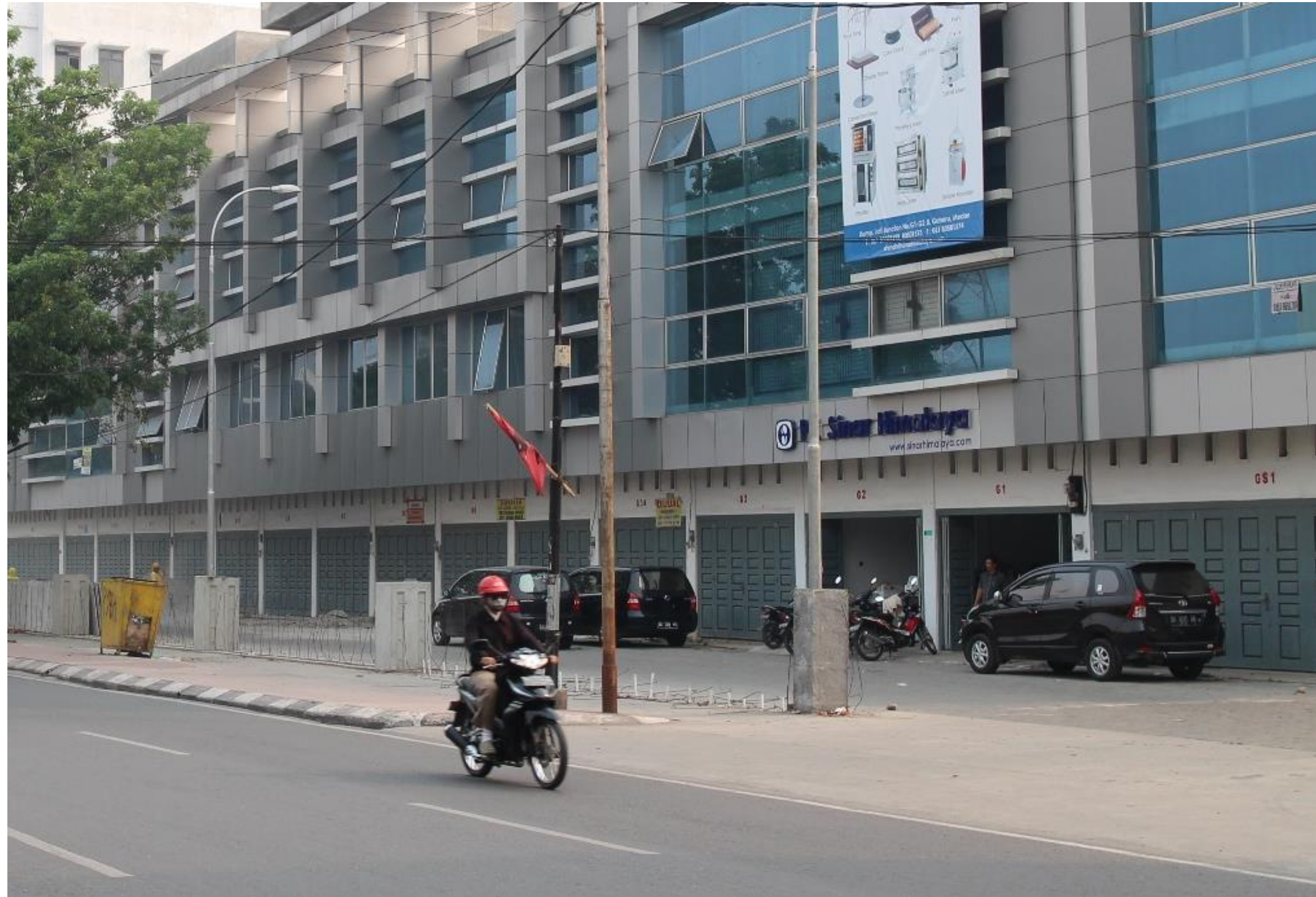
Gambar 3. 18 Foto kondisi eksisting driveway pada Jalan Gaharu, Medan
