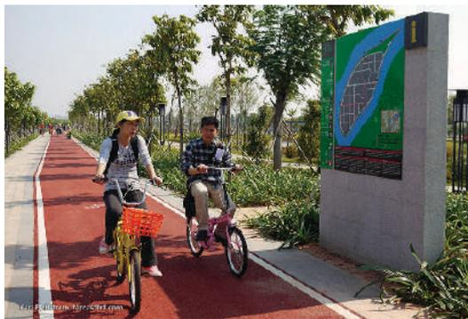
Kanan: Penggunaan cat *cold plastic* untuk marka hijau dan *thermoplastic* untuk marka putih pada permukaan jalan eksisting untuk jalur sepeda di Jakarta
