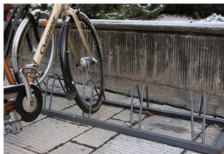
Rak parkir dengan tumpangan untuk ban depan sepeda Sumber: Bike Citizens
