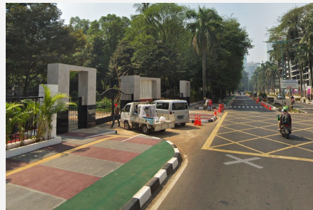
5. Diskontinuitas jalur sepeda akibat transisi permukaan (GBK, Jakarta Selatan) Sumber: Google Earth, 2019
