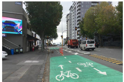
Penerapan jalur sepeda di Auckland. Jalur sepeda dengan proteksi speed bump yang masih dapat dilintasi oleh kendaraan bermotor Sumber: bikeauckland.org
