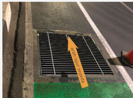
Penempatan alur grating manhole utilitas yang direkomendasikan dengan celah < 20 mm dan beda ketinggian < 3 mm
