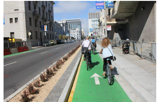
Penerapan jalur sepeda terproteksi 1-arah di New York City, Amerika Serikat dengan proteksi menggunakan median dan tanaman Sumber: Alta Planning
