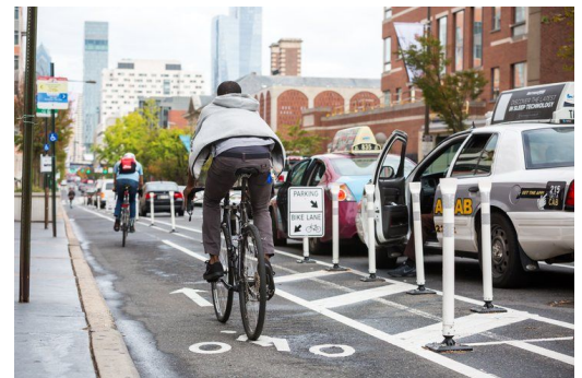
Penerapan jalur sepeda terproteksi 1-arah di Philadelphia, Amerika Serikat di sisi parkir on-street Sumber: PhillyVoice
