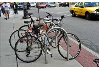
Tipe parkir dengan tiang U terbalik Sumber: Cycle Safe
