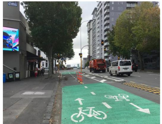
Penerapan jalur sepeda di Auckland. Jalur sepeda dengan proteksi speed bump yang masih dapat dilintasi oleh kendaraan bermotor
