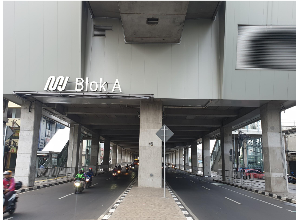
Stasiun Layang MRT Blok A
