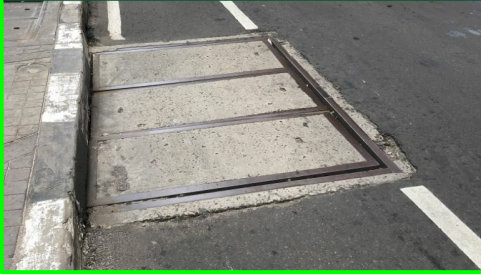
Manhole tanpa overlay
