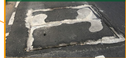
Manhole dengan overlay yang tidak rata
