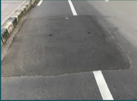
Manhole dengan overlay aspal
