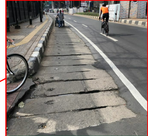
Saluran air yang menggunakan badan jalan sepanjang \pm 200 m
