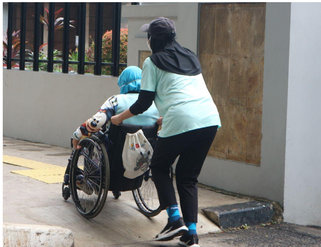
Ram trotoar yang masih curam untuk dilalui pengguna kursi roda secara mandiri
