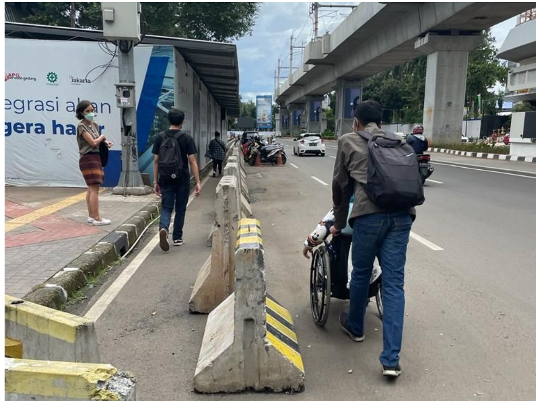
Akses sementara saat ada pembangunan infrastruktur harus dipastikan tetap aksesibel
