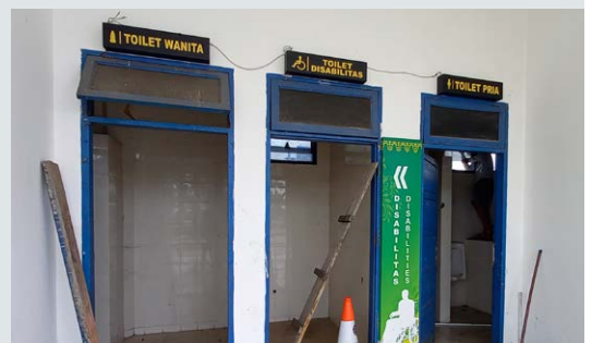
Toilet khusus penyandang disabilitas yang sedang dibangun
