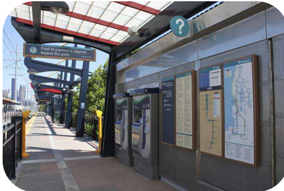
Gambar 8.34 Foto informasi penumpang (atas) dan tempat sampah (bawah) halte bus. sumber: NACTO National Association of City Transportation Officials
