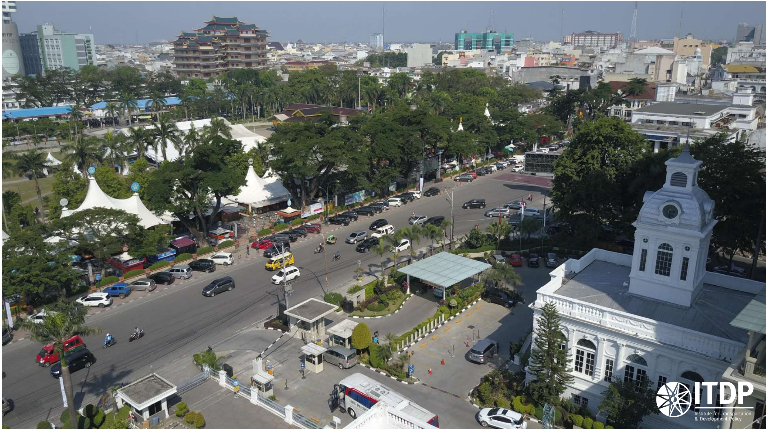
Gambar 8.22 Kondisi eksisting lokasi Stasiun Lapangan Merdeka di Jalan Balai Kota
