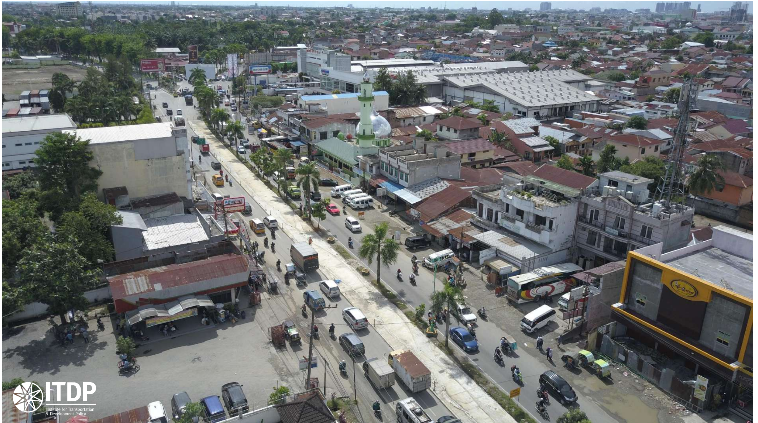
Gambar 8.16 Kondisi eksisting lokasi Stasiun Masjid Jami di Jalan Sisingamangaraja
