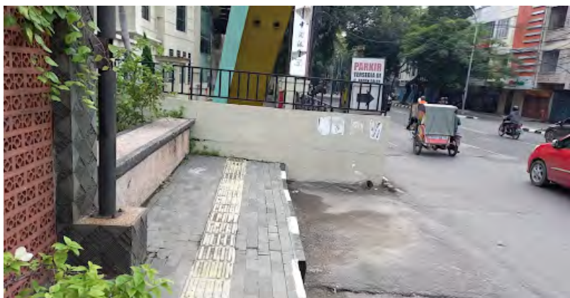
Gambar 18. Jalur pedestrian dan jalur pemandu yang terputus di kawasan jembatan Sungai Deli di dekat Kantor Walikota (ITDP Indonesia, 2021)
