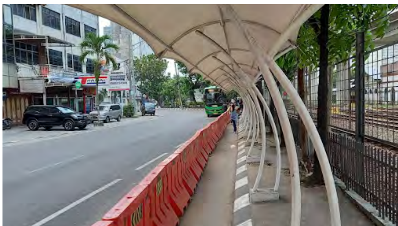
Gambar 37. Kanopi penghubung Halte Lapangan Merdeka yang strukturnya memenuhi ruang trotoar eksisting (ITDP Indonesia, 2022)
