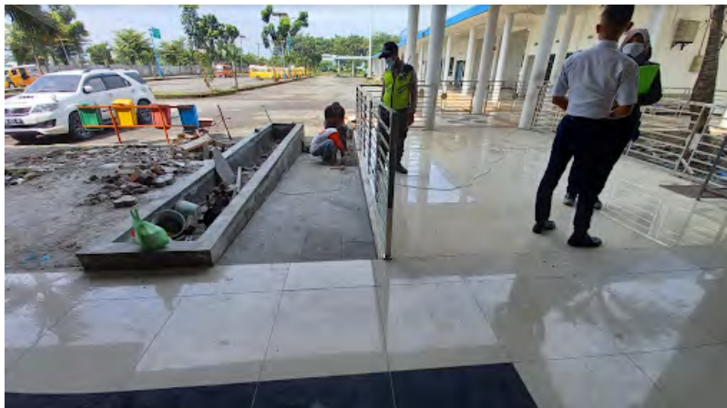
Gambar 57. Ramp pada sisi selatan gedung terminal utama (ITDP Indonesia, 2021)
