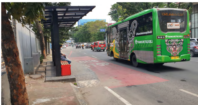
Gambar 36. Ramp dan ruang tunggu penumpang menjorok ke ruang jalan tanpa intervensi keselamatan yang cukup pada Halte Lapangan Merdeka (ITDP Indonesia, 2022)
