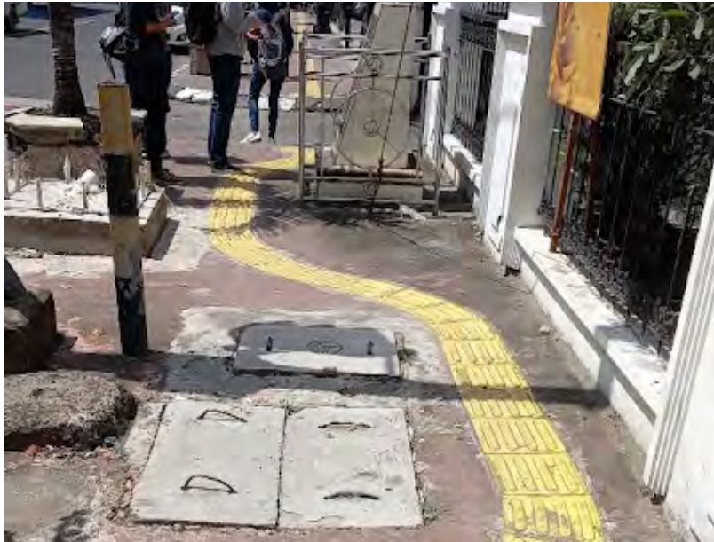
Gambar 72. Jalur pemandu yang berkelok menghindari manhole utilitas di Jalan Balai Kota
