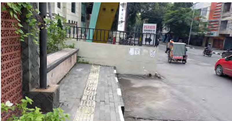
Gambar 18. Jalur pedestrian dan jalur pemandu yang terputus di kawasan jembatan Sungai Deli di dekat Kantor Walikota (ITDP Indonesia, 2021)
