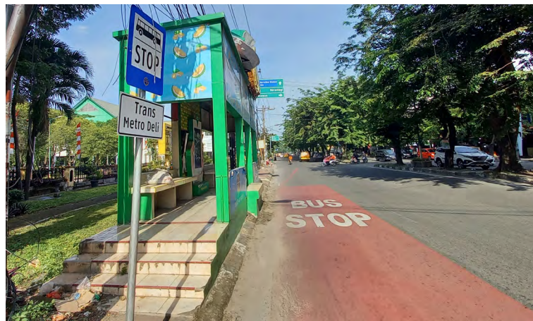
Gambar 39. Gambar halte dengan lantai tinggi (ITDP Indonesia, 2021)
