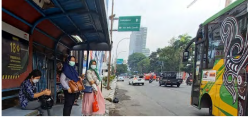
Gambar 44. Kondisi lampu neon Halte Balai Kota (ITDP Indonesia, 2021)
