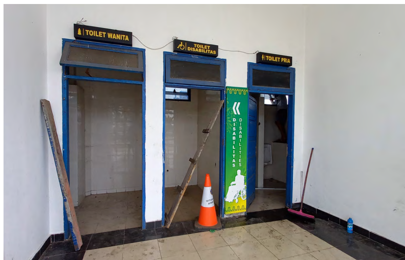
Gambar 59. Fasilitas toilet berkebutuhan khusus yang tampak sedang direnovasi (ITDP Indonesia, 2021)
