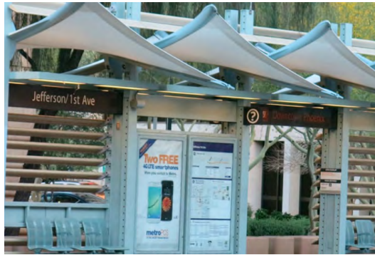
Gambar 66: Stasiun LRT Pheonix, Arizona, USA yang menyediakan peneduh dan aliran udara (Sumber: ITDP)
