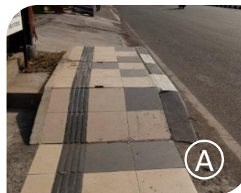
(A) Tinggi trotoar yang berbeda-beda; (B) Minimnya fasilitas penyebrangan yang memadai; (C) Tidak adanya fasilitas pejalan kaki di radius >5 km
