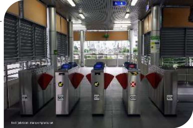
Mesin tap-in dan tap-out untuk pembayaran non-tunai di stasiun BRT
