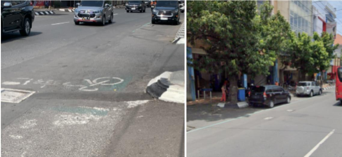
**Gambar 2.2 Kondisi jalur sepeda di Jalan Gajah Mada yang menunjukkan pudarnya marka dan okupansi oleh parkir kendaraan bermotor**
