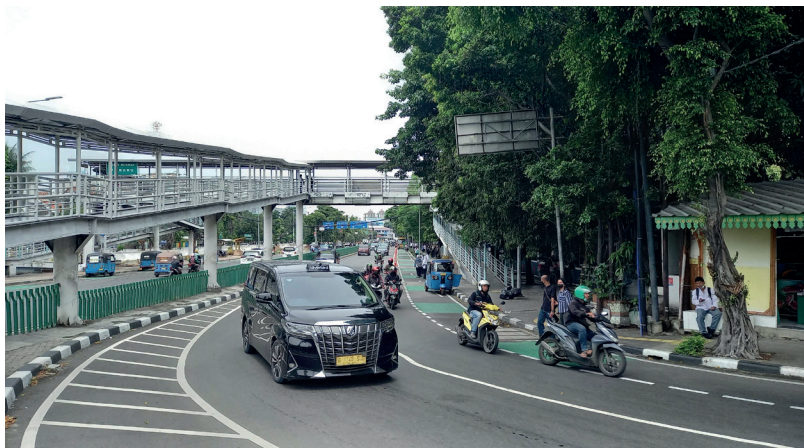
Gambar 2.6 Penyeberangan tidak sebidang di Halte Transjakarta Pasar Baru di Jalan Dr. Sutomo (sumber: ITDP Indonesia, 2022)
