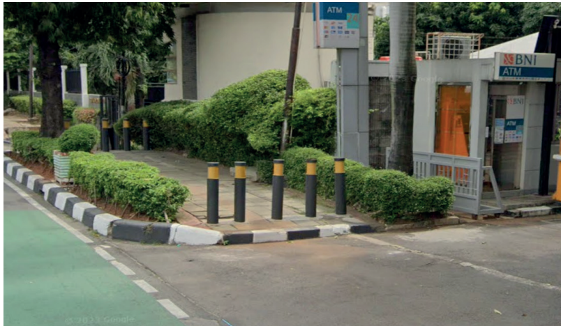
Gambar 2.4 Jalur pejalan kaki yang tidak menerus dan sulit diakses oleh penyandang disabilitas di Jalan Letjen S. Parman, Jakarta Barat (sumber: Google Earth, 2022)
