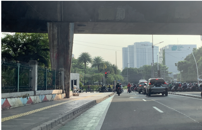
Gambar 2.2 Pembangunan jalur pejalan kaki dan sepeda yang tidak sinergis di Jalan Pegangsaan Barat, Jakarta Pusat (sumber: ITDP Indonesia, 2021)
