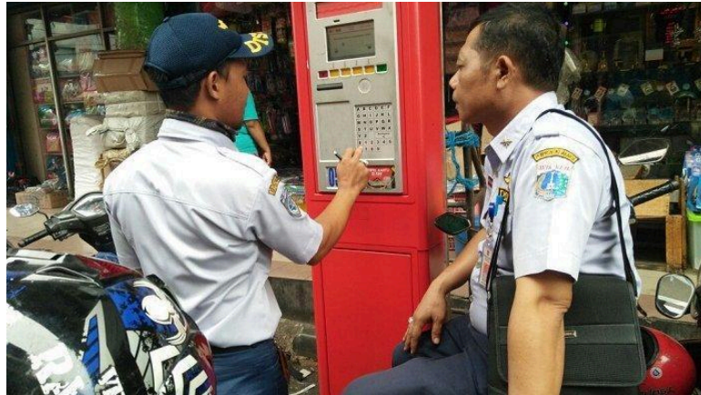
Gambar 13. Terminal Parkir Elektronik pada fasilitas parkir di ruang milik jalan di Jakarta
