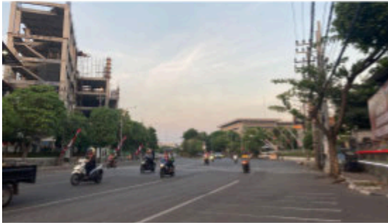
Ruang jalan yang lebar dan kecepatan kendaraan tinggi cukup menyulitkan pejalan kaki menyeberang dari halte.
