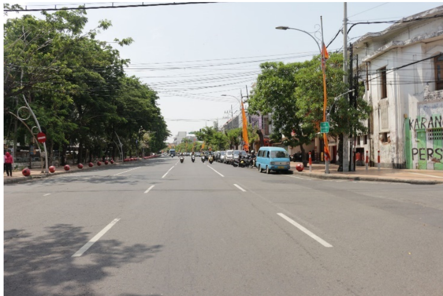
Gambar 46. Kondisi Eksisting Jalan Rajawali
