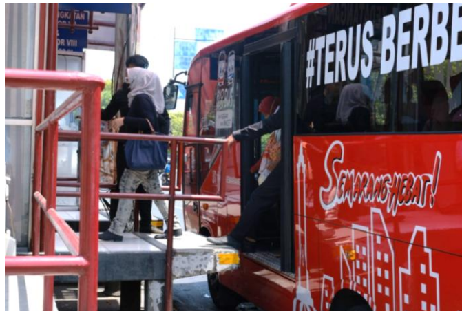
Gambar 60. Celah horizontal dan vertikal antara peron halte dengan lantai bus di Halte Balai Kota Sumber: ITDP Indonesia (2024)
