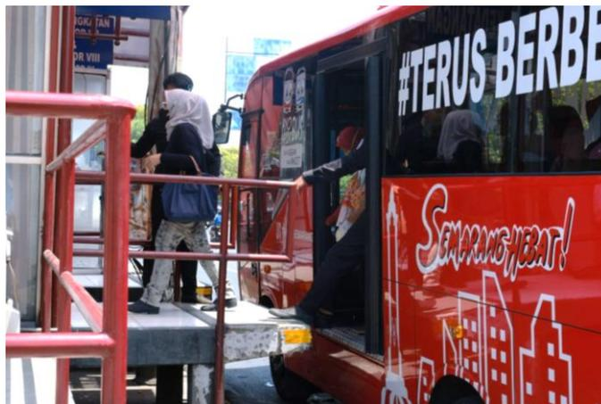
Gambar 60. Celah horizontal dan vertikal antara peron halte dengan lantai bus di Halte Balai Kota
