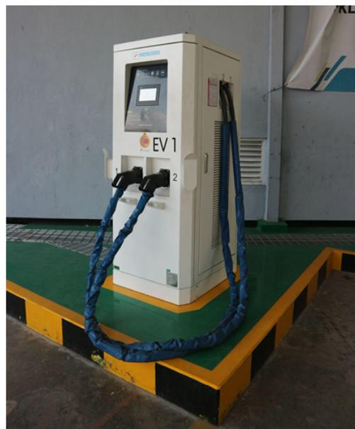
Gambar 36. Pengisi Daya Double Gun Bertipe Plug-in DC CCS2, dengan Keluaran Daya Maksimum 200 kW oleh Powerindo Prima yang Digunakan pada Depo Operator
