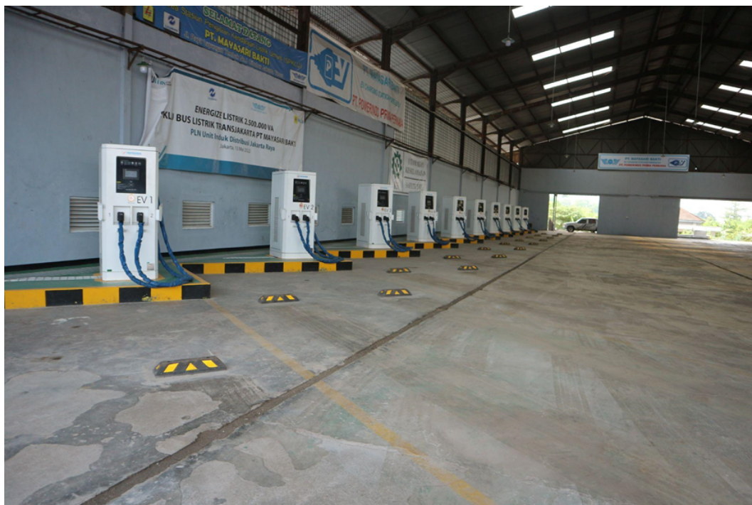
Gambar 40. Infrastruktur Pengisian Daya pada Depo Operator Bus Listrik Transjakarta
